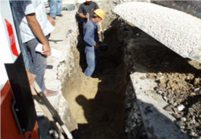
Mit Sand den Unterbau und die Drainageschicht vorbereiten
