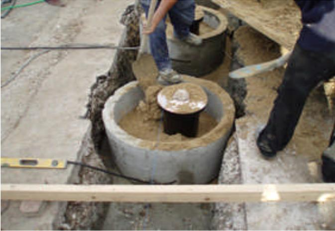
Betonrohr mit Sand füllen und einschwemmen.
