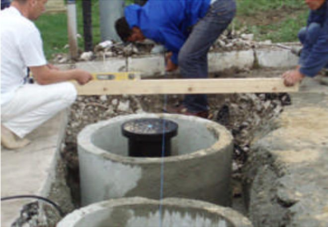
Stoppys in das Betonrohr stellen, an das Bodenniveau anpassen und ausrichten.
